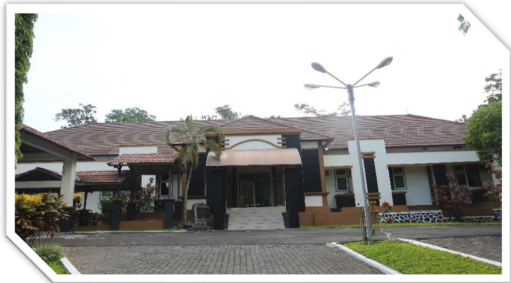
Gambar 25. Gedung Asrama B2P2VRP
